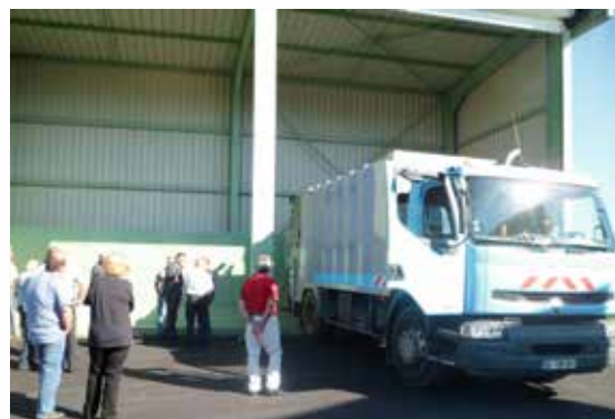
Quai de transfert de Les Magny
